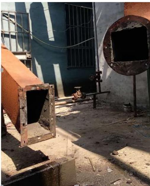
燃煤锅炉排气筒断开照片
