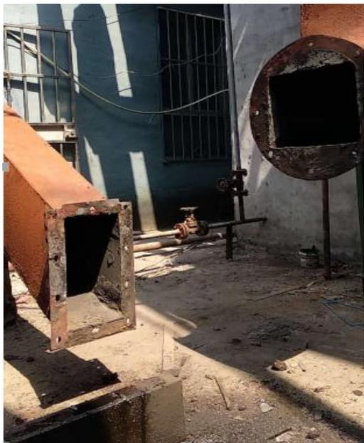
燃煤锅炉排气筒断开照片
