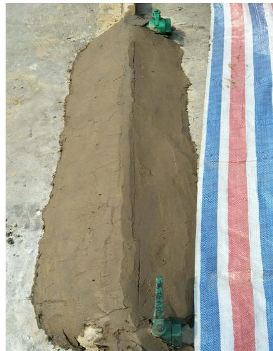
围堰初期雨水阀及后期雨水阀
